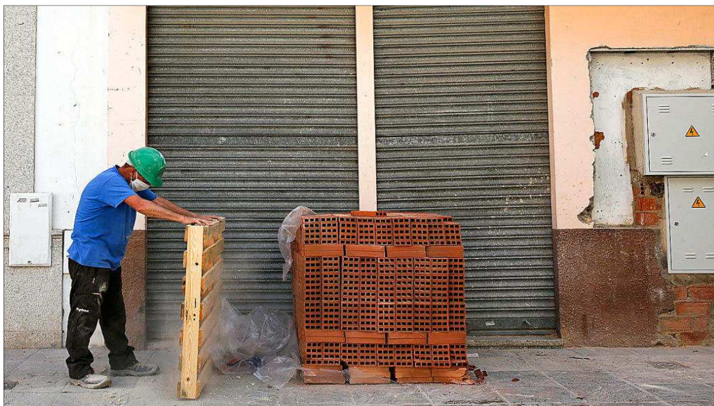
Un empleado del sector de la construcción trabajando en unas obras de reforma en Sevilla. GETTY IMAGES
