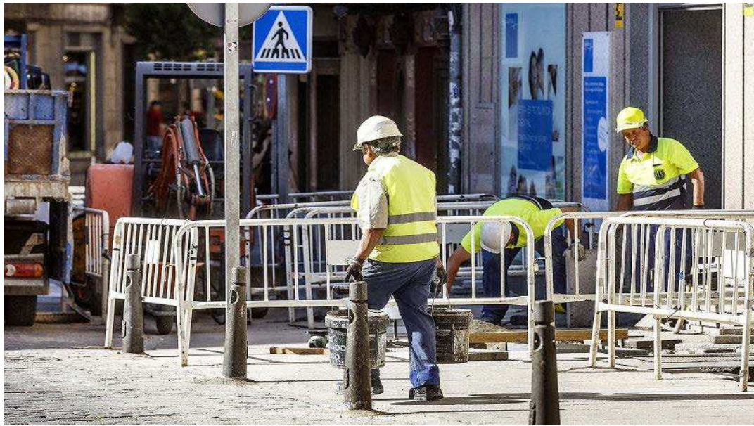
Trabajadores en una obra en Segovia capital. / FOTOGRAFÍA DE ROSA BLANCO
