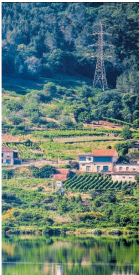
Tendido eléctrico en Castrelo de Miño (Ourense), ayer.
