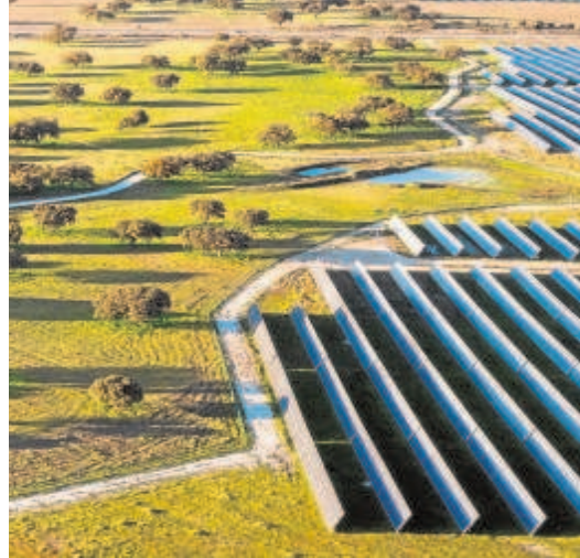
Reducto de biodiversidad Derecha y foto de portada, planta de Talayuela donde se han adoptado medidas para conservar el entorno
