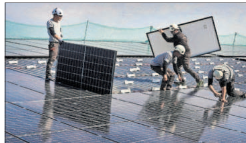
Instalación de placas solares este febrero en Vic (Barcelona). / C. CASTRO
