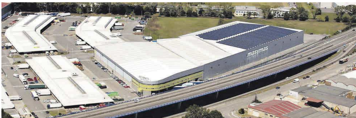
Vista de la instalación de paneles solares fotovoltaicos en la cubierta de las oficinas y la plataforma logística integral de los supermercados Masymas.
