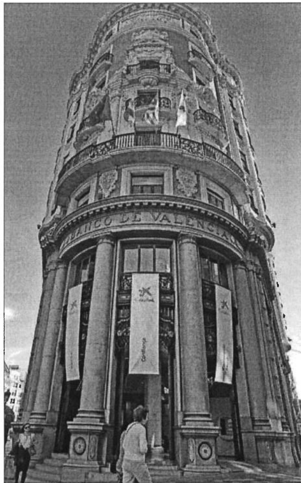
Sede central de Caixabank en Valencia. / MÓNICA TORRES
