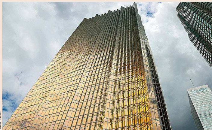
Royal Bank Plaza cuenta con dos torres de 180 y 112 metros de altura, respectivamente.
