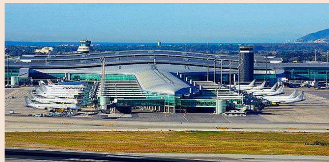
La icónica espada que se construyó en la ampliación de El Prat en 2009. ¿Será la definitiva?
