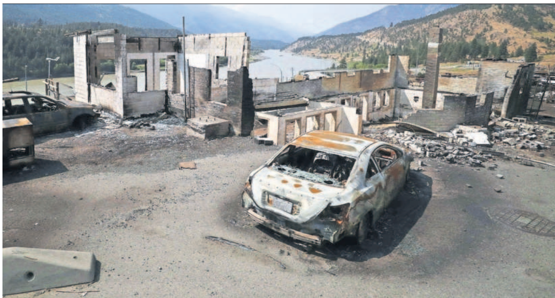
Estructuras y coches dañados por el fuego en Lytton (Canadá), en junio. / D. DYCK (ZUMA PRESS)
