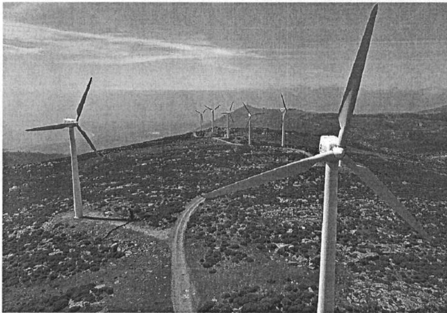
Imagen de aerogeneradores en un parque eólico.
